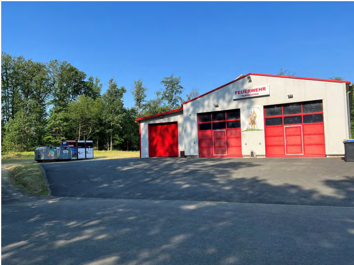
Foto 3: Blick auf das Feuerwehrgrundstück, welches im Norden direkt angrenzt (Quelle: Ingenieurbüro Zillinger, Juni 2023)
